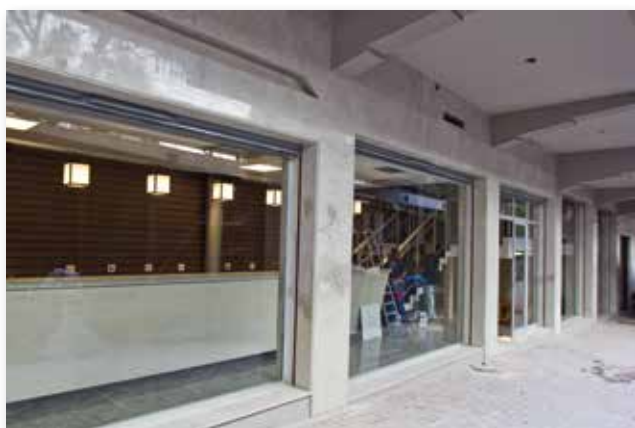
Vista externa do pavimento térreo, voltada para a Rua dos Carijós. (2013)
