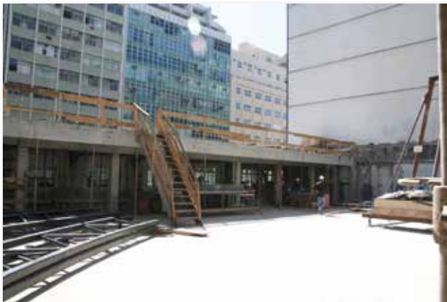
Obras de edificação do Terraço Brasil. (2008).
