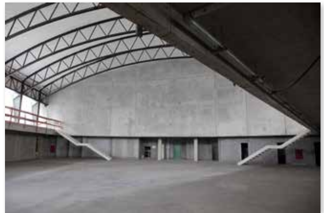
Espaço Terraço Brasil, já com cobertura. (2010)
